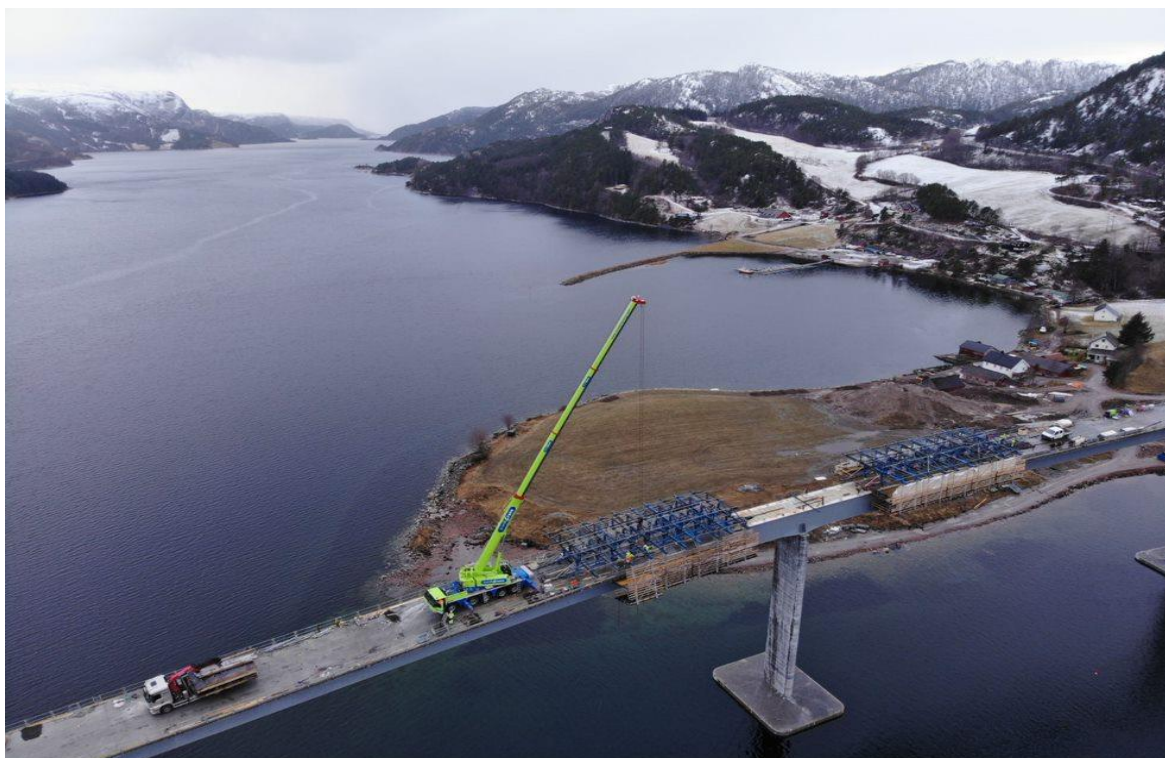
Obr. 33 Betonářské vozíky DOKA pro betonáž mostovky
