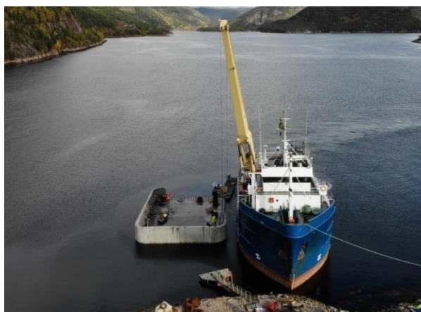
Obr. 9 Osazení prefabrikátů – suchá jímka
