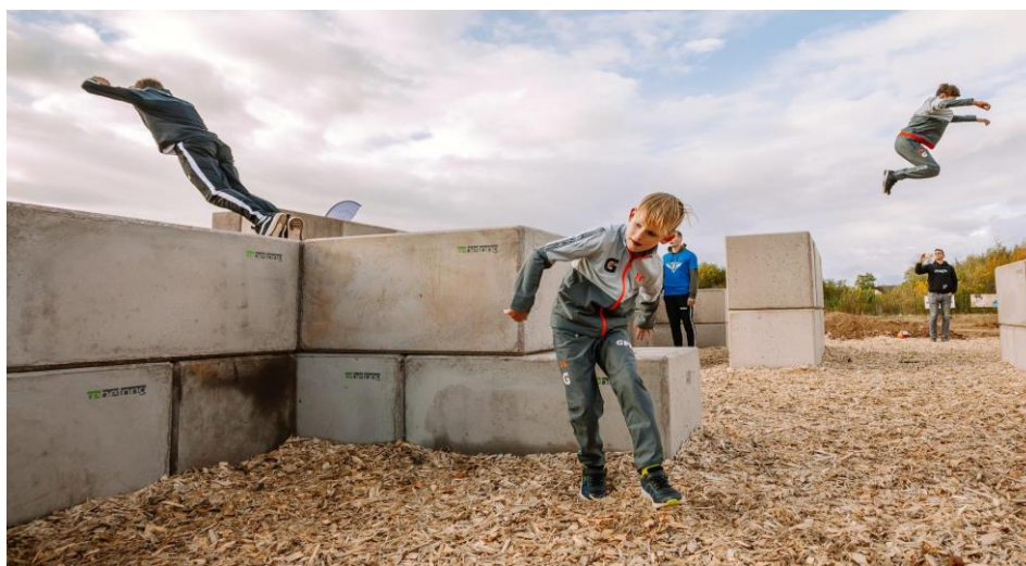
Obr. 6 První pilotní projekt z Rebetongu ve formě prefabrikovaných stěnových dílců ReBlok – parkourové hřiště v Praze, Modřanech
