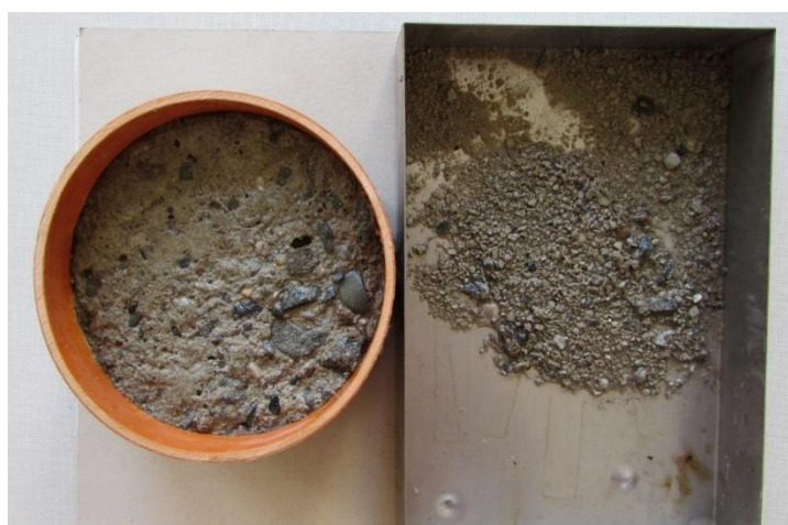
Obr. 1 Zkušební těleso 1 po zkoušce odolnosti proti CHRL včetně odpadu z povrchu tělesa
