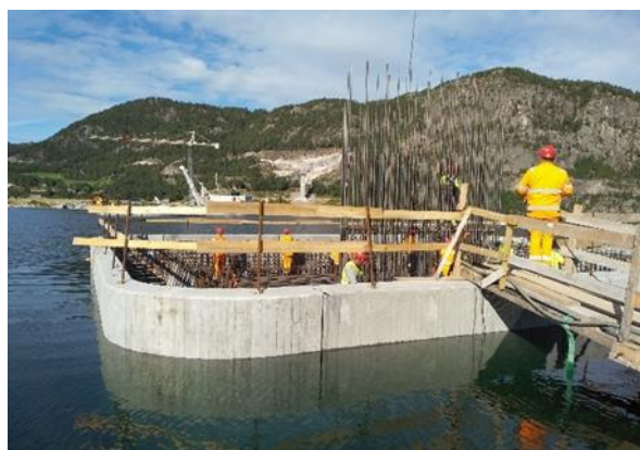
Obr. 13 Armatura základu
