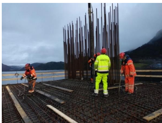
Obr. 14 Betonáž základu
