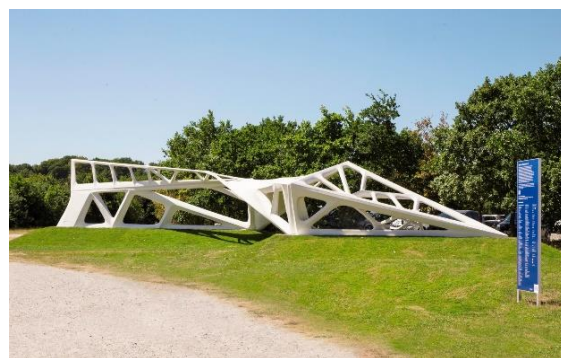
Obr. 18 Topologicky optimalizovaná konstrukce z UHPC Arhuská škola. Dánsko
