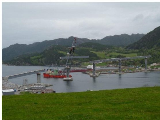
Obr. 31 Montáž ocelové konstrukce
