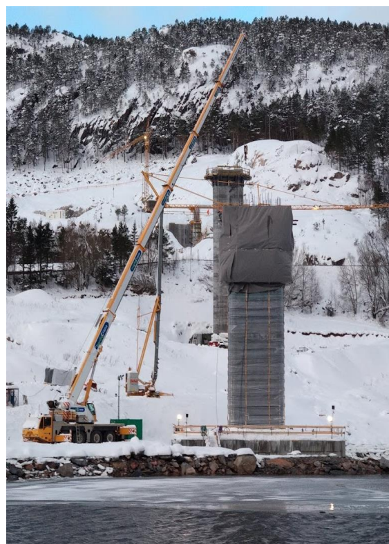
Obr. 26 Betonáž pilířů-tažené bednění
