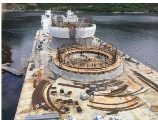
Obr. 18 Realizace studní na pontonu
