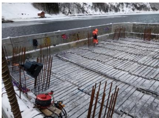
Obr. 12 Armatura základu
