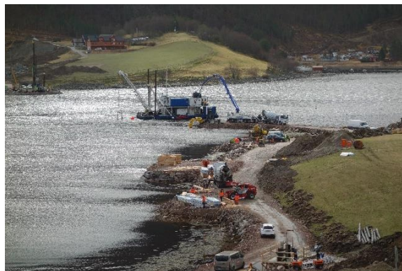
Obr. 17 Podvodní betonáž
