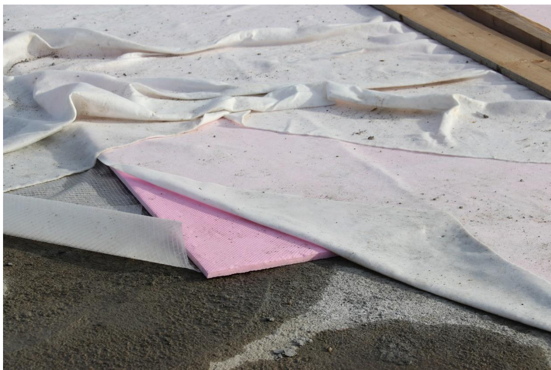
Obr. 9 Opatření (zakrytí betonu) aplikované hned po betonáži.
