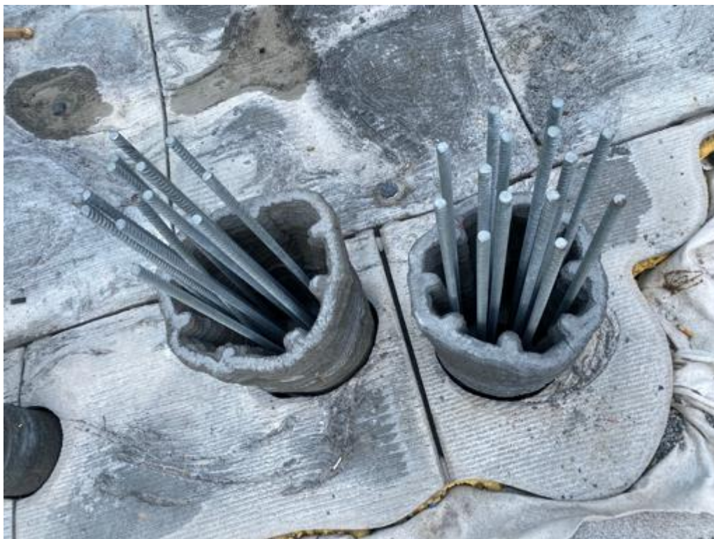
Obr. 6 Instalovaná část nohy sochy z UHPC
