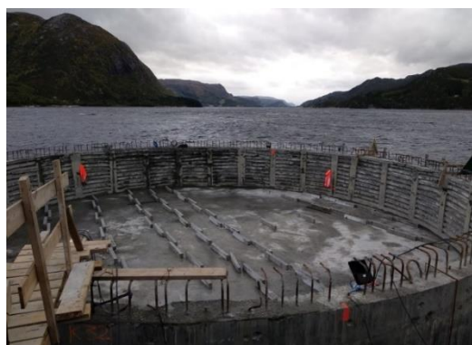
Obr. 23 Podkladní beton
