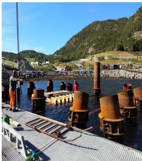
Obr. 8 Ocelový rošt osa 5,6
