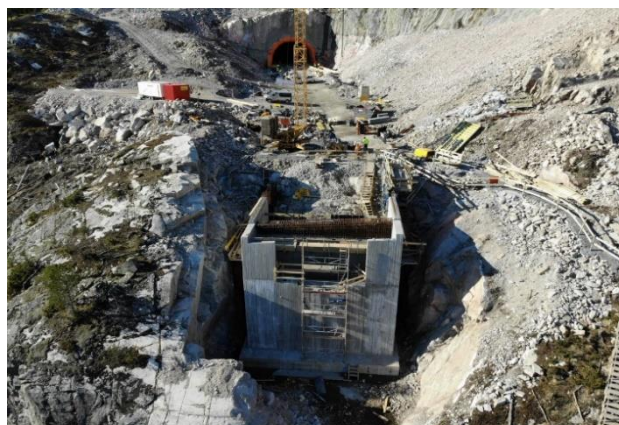
Obr. 3 Opěra 9 ve skalním masivu
