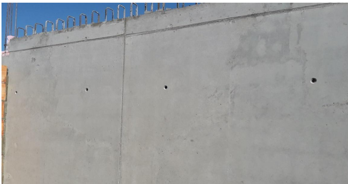
Obr. 9 První železobetonová stěna z Rebetongu na projektu Čertův Vršek v Praze
