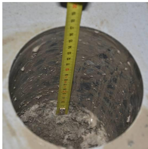
Obr. 5 Jádrový vývrt, z něhož byla zjištěna průměrná hodnota tloušťky podlahy 171,5 mm
