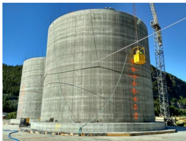
Obr. 19 Dokončení studní na pontonu
