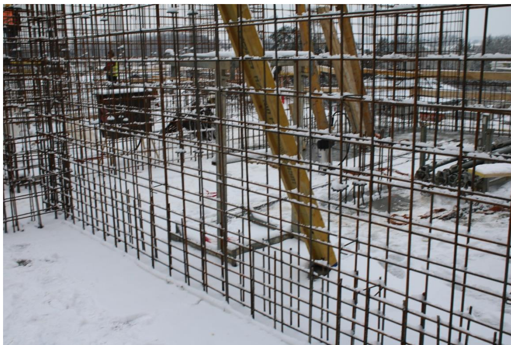
Obr. 3 Přípravenost staveniště v den betonáže.
