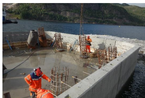
Obr. 11 Zabetonovaná pilota v suché jímce
