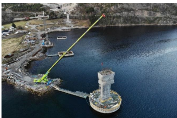
Obr. 25 Betonáž pilířů-tažené bednění
