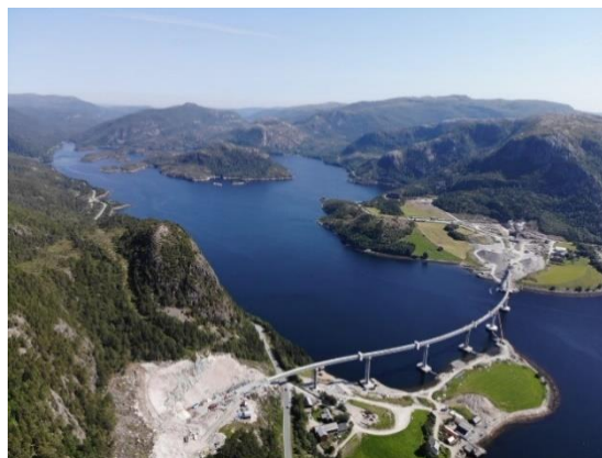
Obr. 32 Osazená ocelové konstrukce
