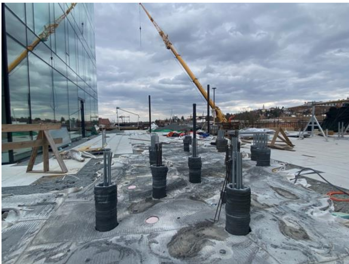
Obr. 8 Instalace sochy na prostranství mezi objekty projektu Bořislavka, Praha 6. Prozatím je extrudován a instalován rezervoár a části nohou sochy
