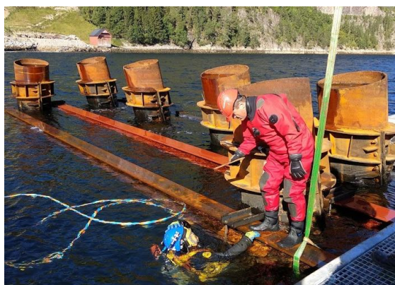
Obr. 7 Ocelový rošt osa 5,6
