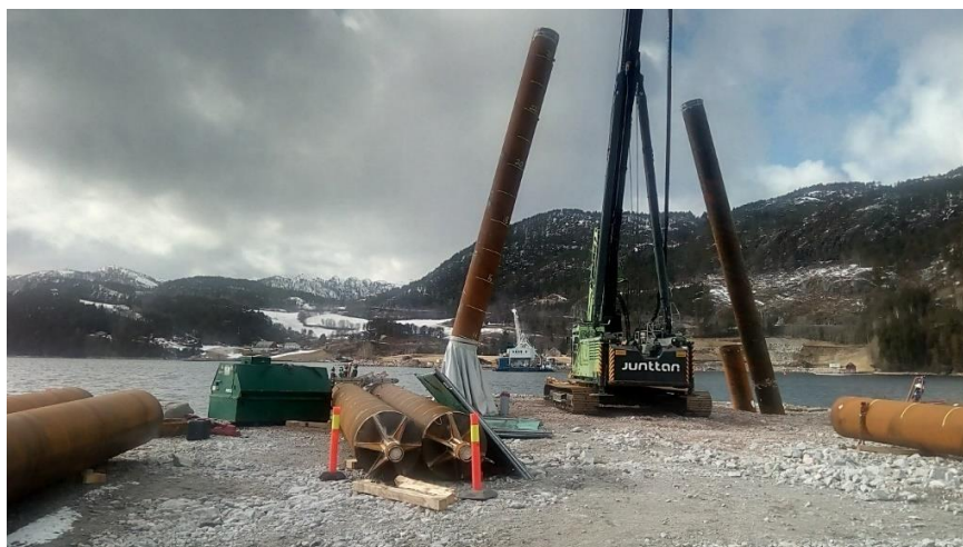
Obr. 4 Ocelová pilota s ocelovým hrotem
