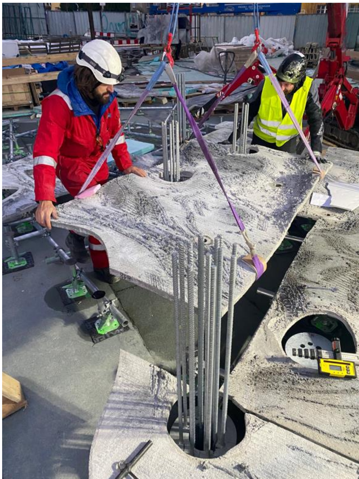
Obr. 5 Instalace extrudované části rezervoáru
