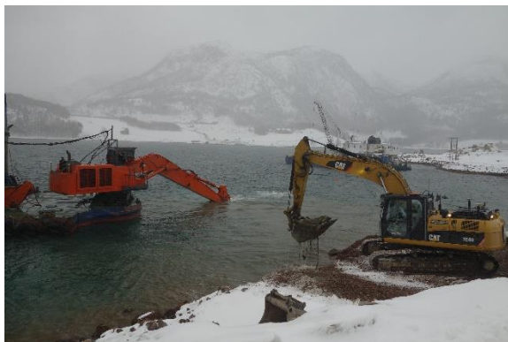
Obr. 16 Hloubení výkopů na dně moře
