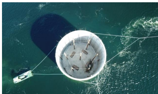
Obr. 21 Přesun studně do definitivní pozice
