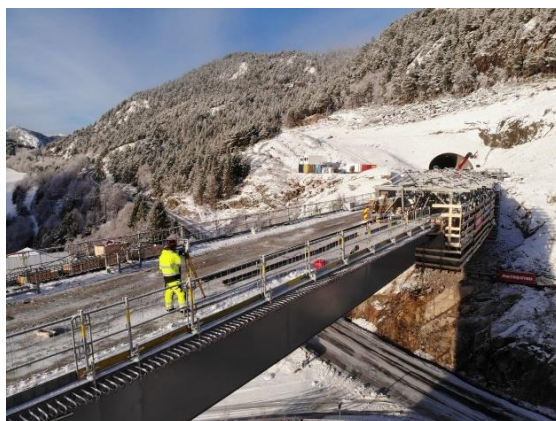
Obr. 34 Betonářský vozík DOKA pro betonáž říms
